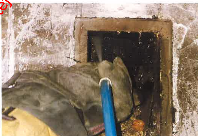
Fot. 4 Gaszenie pożaru sadzy w przewodzie kominowym (zdjęcie wykonane podczas ćwiczeń)
