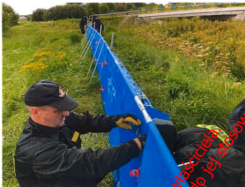
Fot. 9 Łączenie podstawowych elementów stelażowych ze sobą
