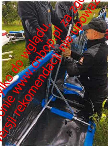
Fot. 8 łączenie podstawowych elementów stelażowych ze sobą
