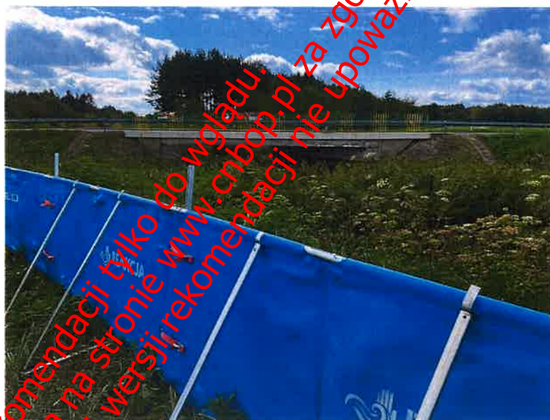
Fot. 10 Stelażowy system przeciwpowodziowy - wersja stacjonarna
